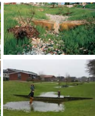
Gecompartimenterde greppel / wadi
