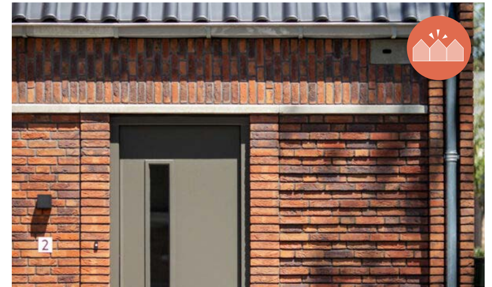
Verfijnde gevel. Passende materialisering en rijke details
